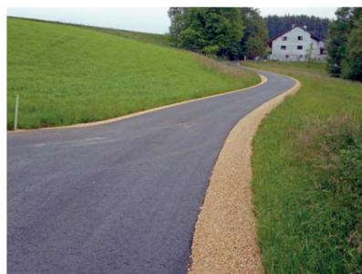
Heuer konnte ein Straßenstück in Mitterberg generalsaniert werden. Hier wurde auch der Unterbau mit Granitbruch „verbessert“, sodass man von einer grundlegenden Instandsetzung ausgehen kann.
